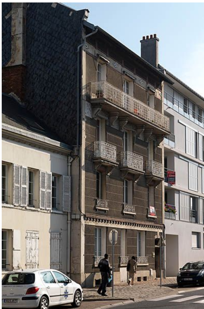
Immeuble au 21bis, boulevard Jean-Rose : façade soignée, avec décor de sgraffite et balcons en ferronnerie 1900.
