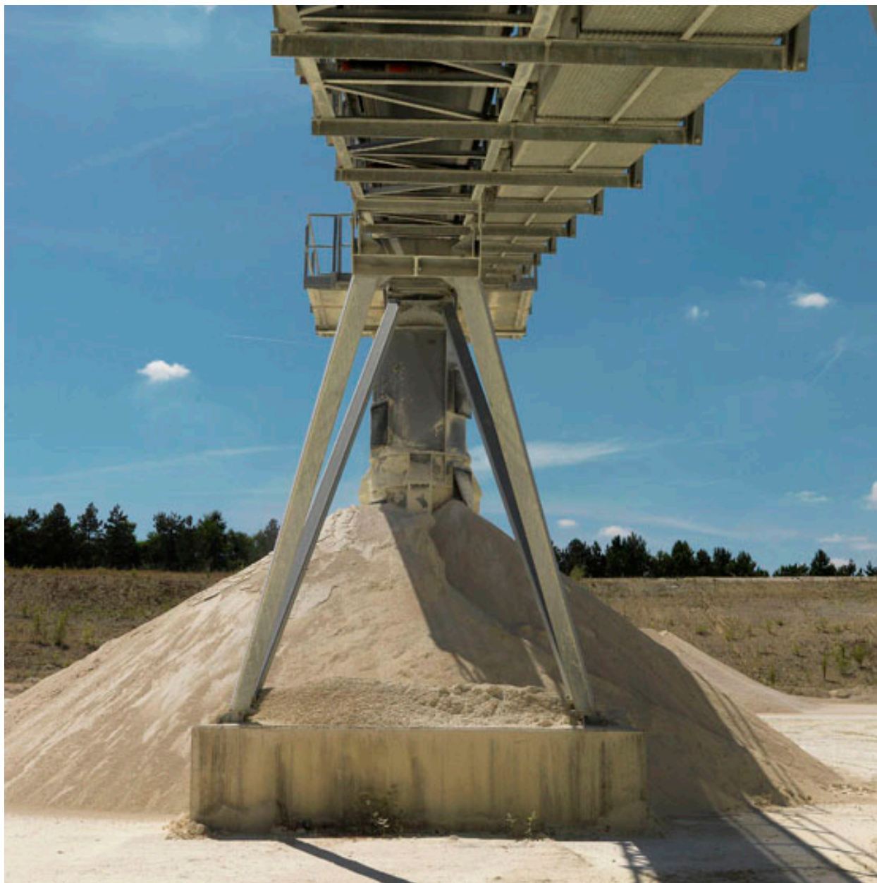
Plateforme - installation secondaire.
