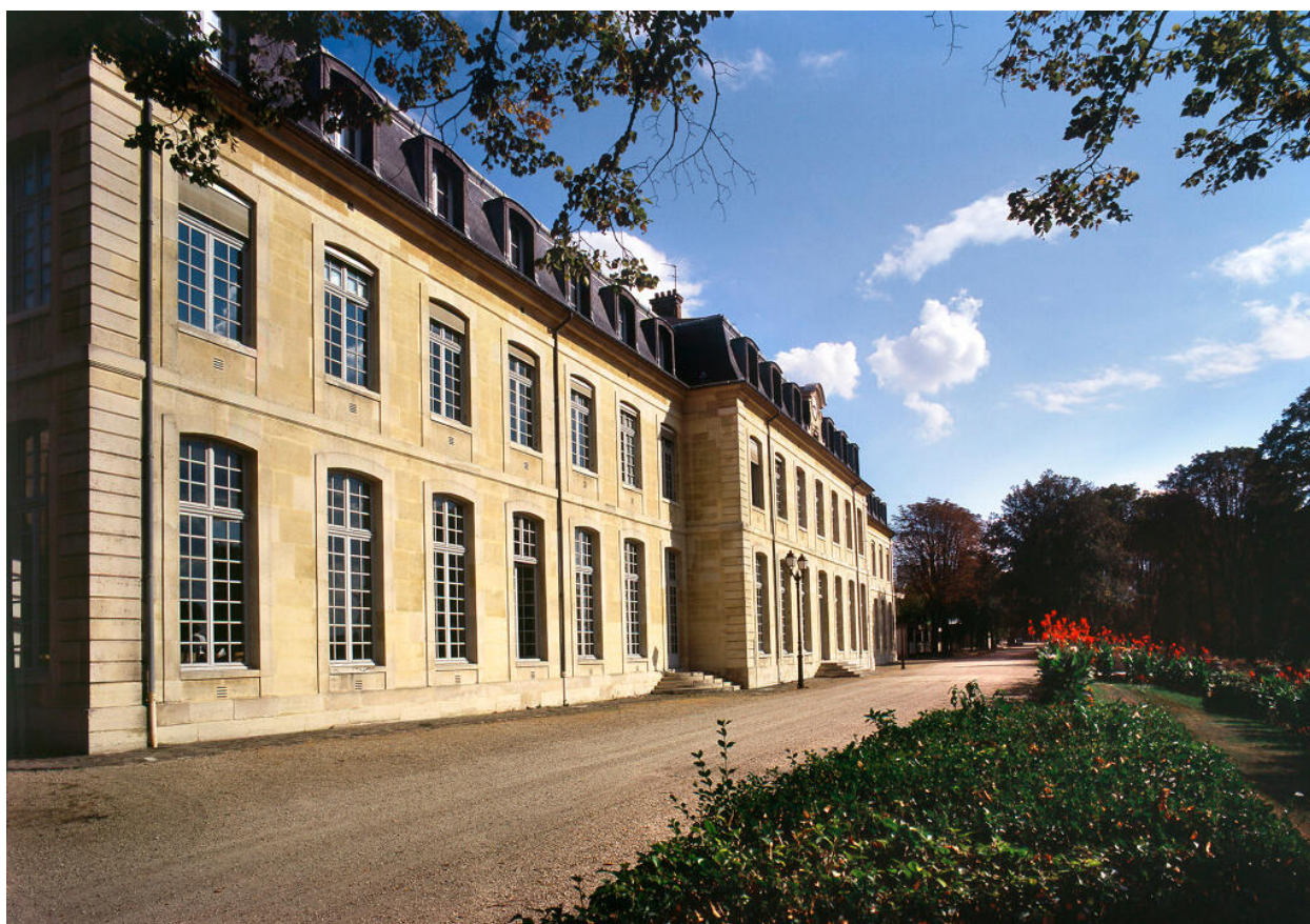
Façade sur le parc du pavillon Mansart et des ailes postérieures.
