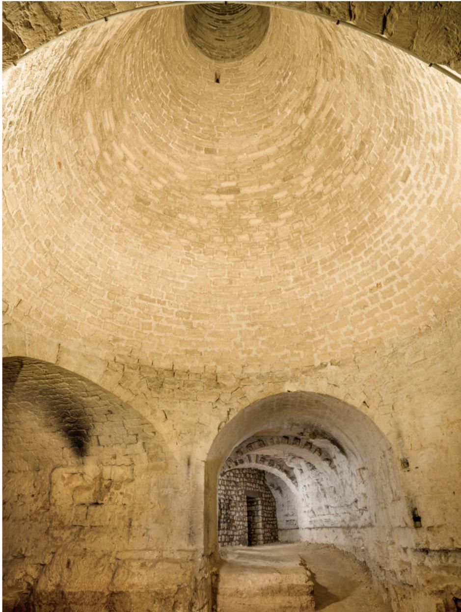
Coupole tronconique de 14 mètres à l'intersection de quatre galeries de circulation charretables, c.1820. Dénommée 'tunnel' (en raison de sa forme similaire aux tonnelles pour la chasse), elle est la pièce centrale d'un système de ventilation des caves.
