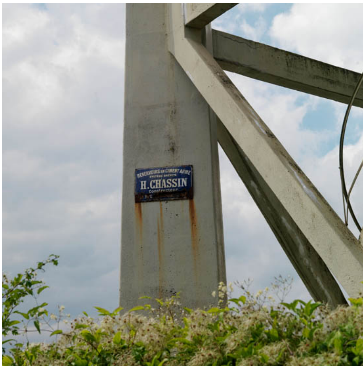
Détail de la structure en ciment armé du château d'eau (1902), construit par H. Chassin.
