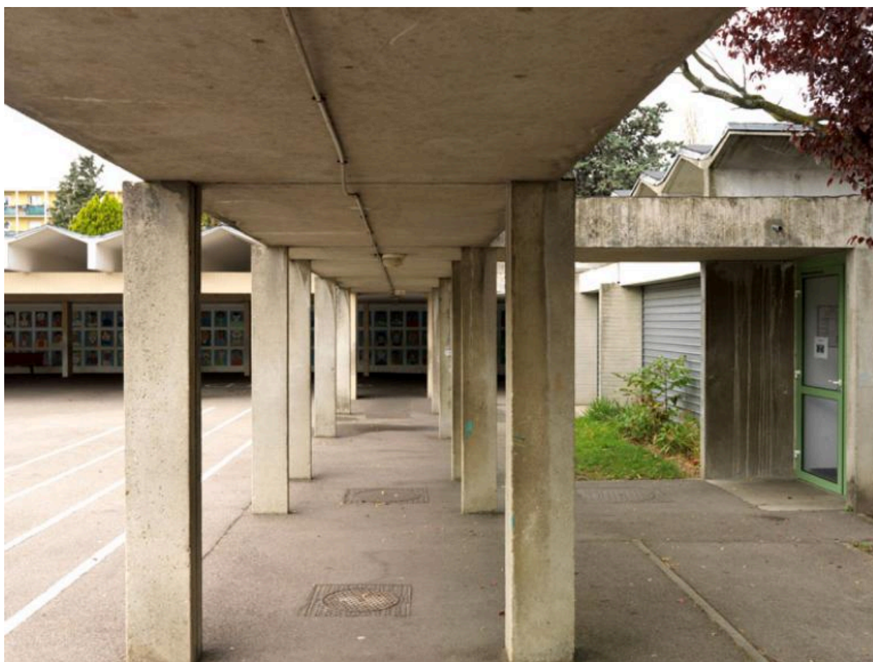
La galerie au niveau du deuxième couloir desservant l'école Rousseau.
