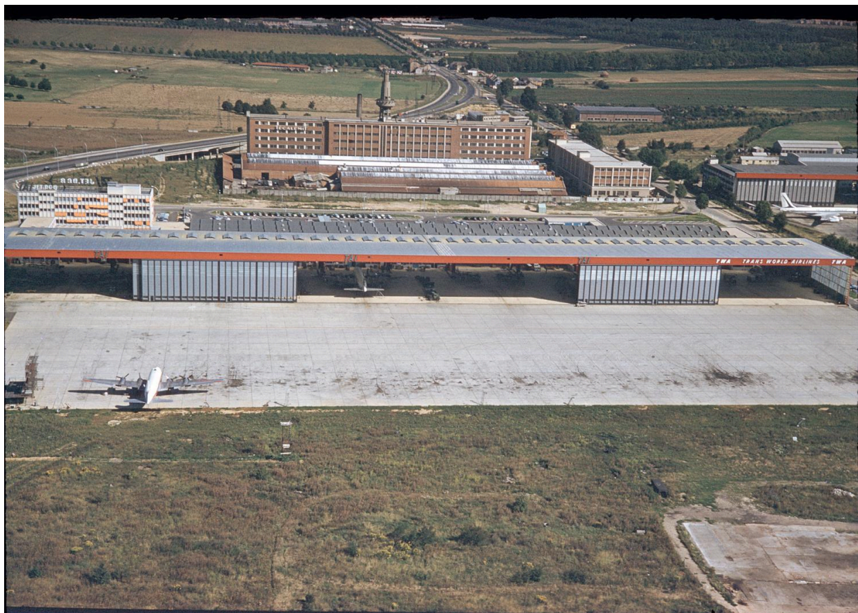
1960, zone industrielle nord de l'aéroport d'Orly, le hangar N6 vu depuis le sud.
