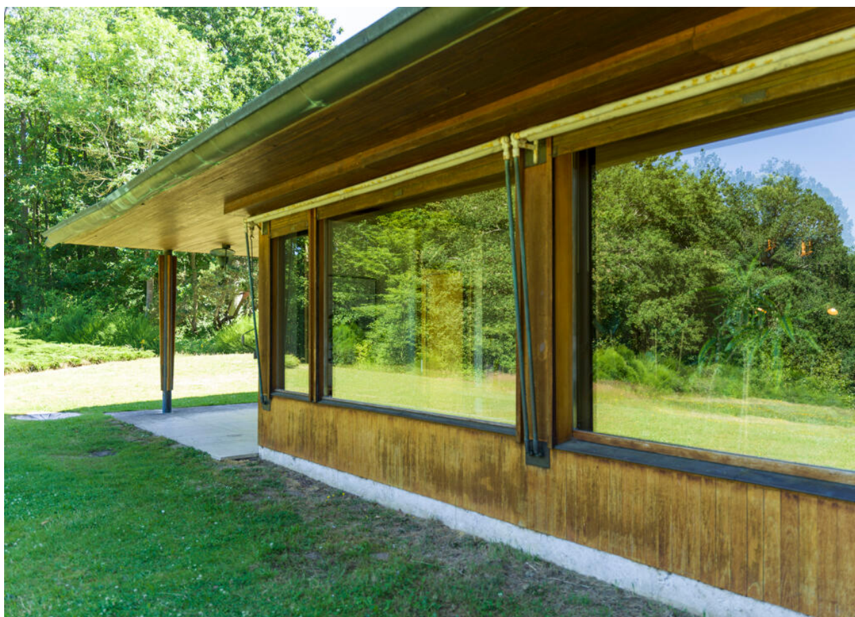
Les baies du salon.
