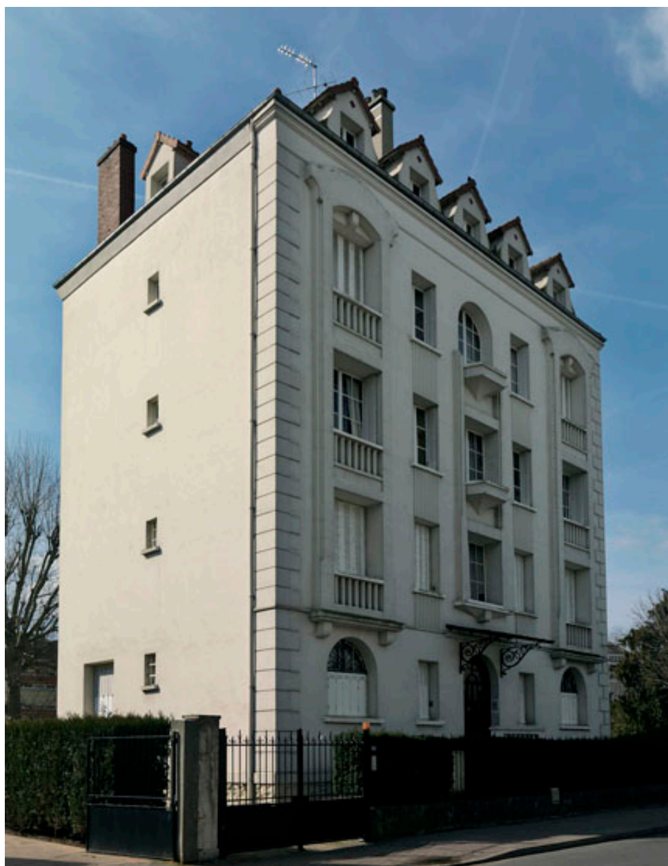
Vue d'ensemble de l'immeuble, depuis la rue.
