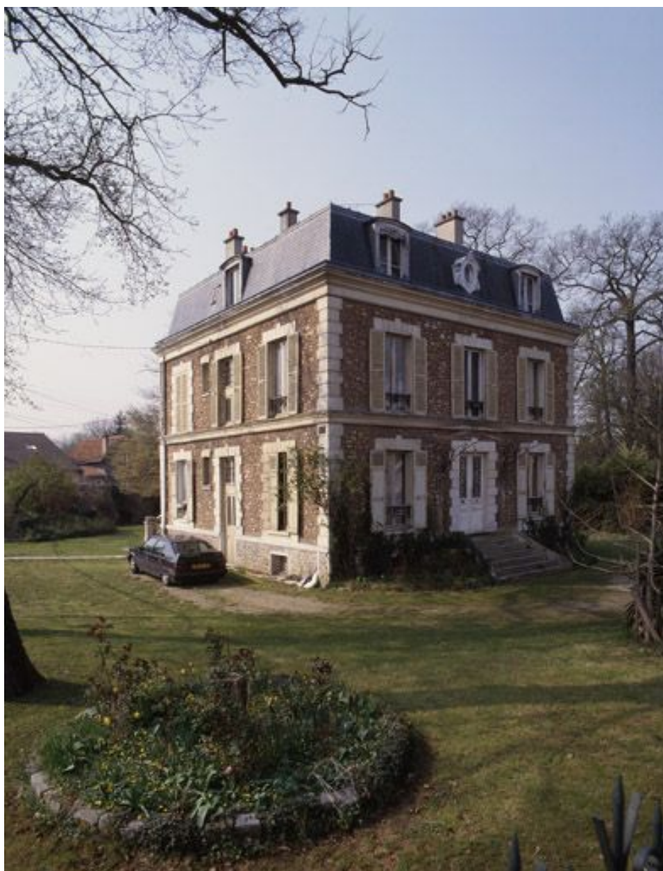
Vue d'ensemble de la maison de notable, 22 avenue Granger.
