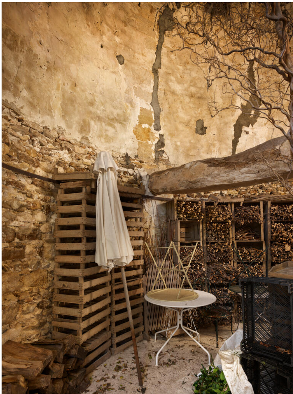
Vue intérieure du colombier.
