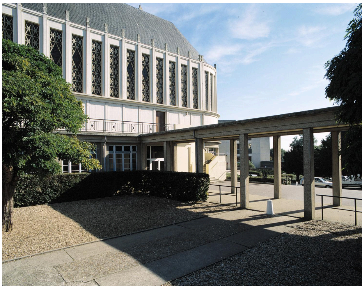
Le portique donnant accès à la cour d'école.
