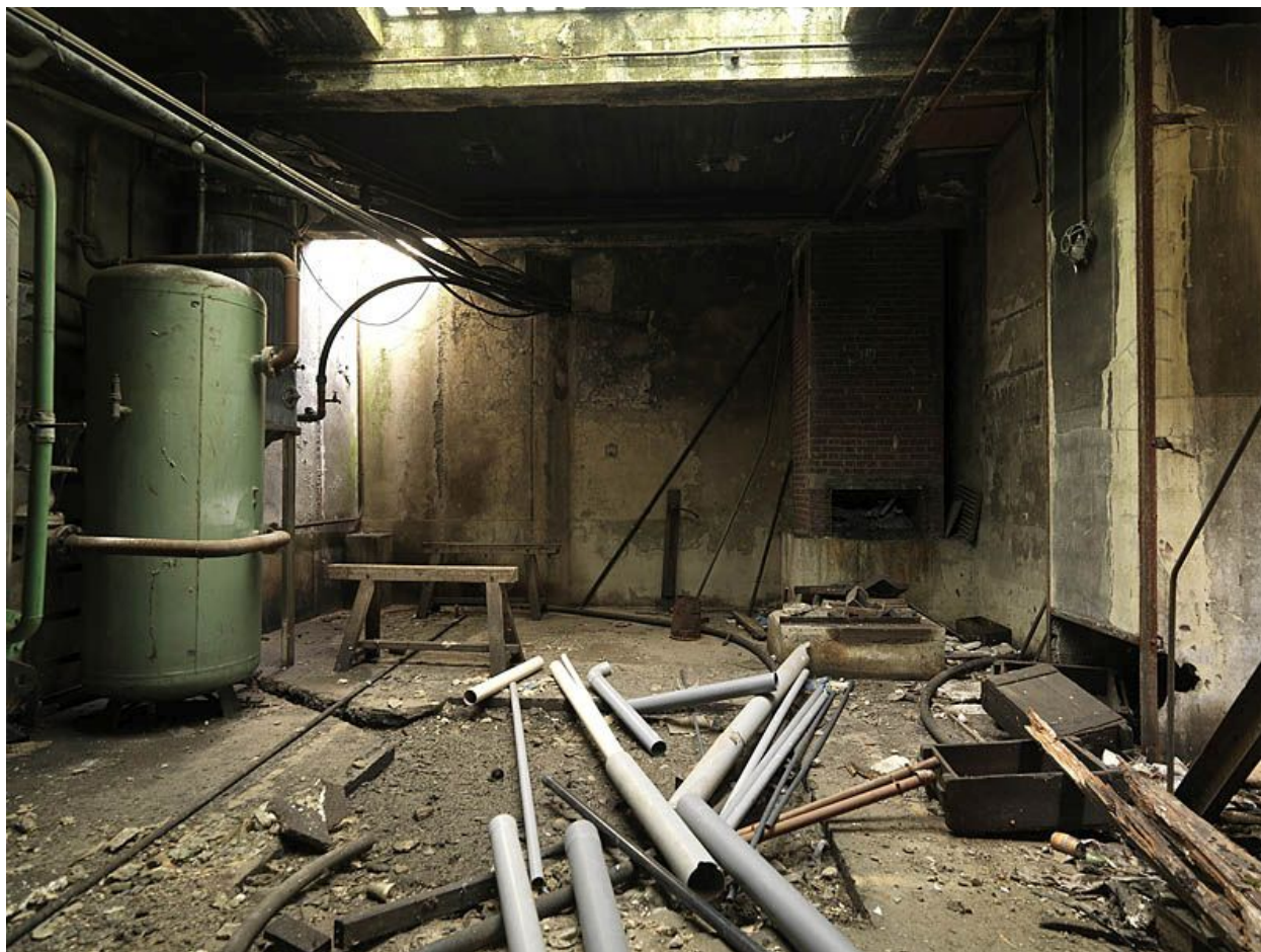
Cave de l'usine Bieth-Humbert destiné à la chaufferie et au charbon.
