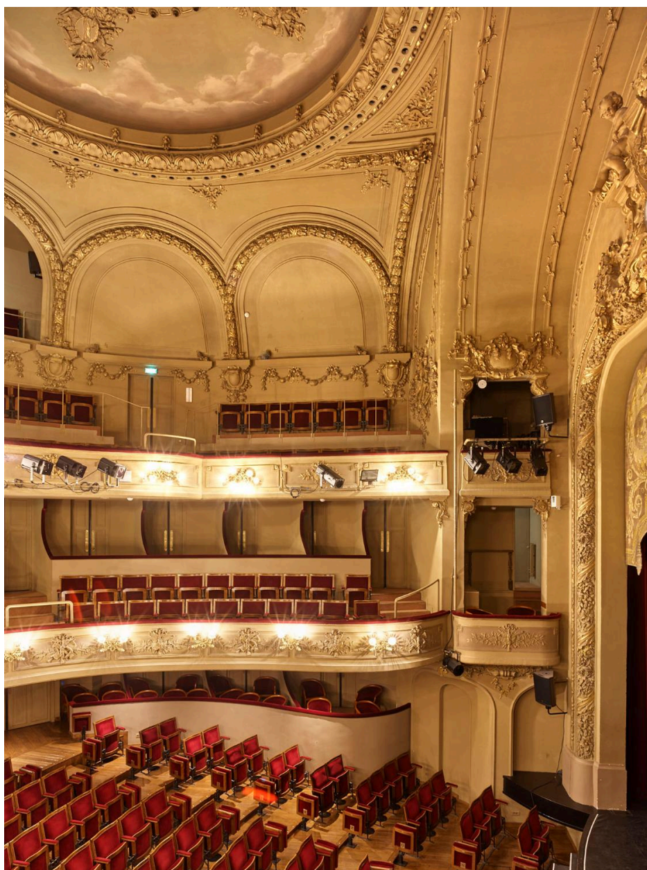
Vue des balcons suspendus sans point d'appui
