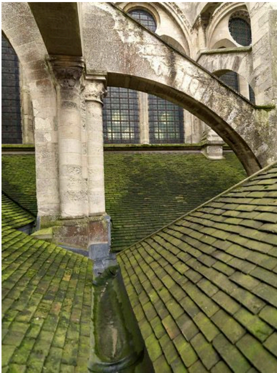
Détail de l'arc-boutant à la jonction de la nef et du transept, côté nord.
