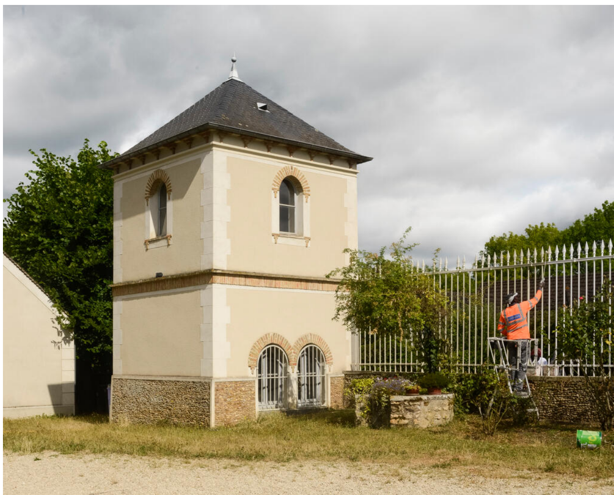
Détail du pavillon ouest de l'entrée.
