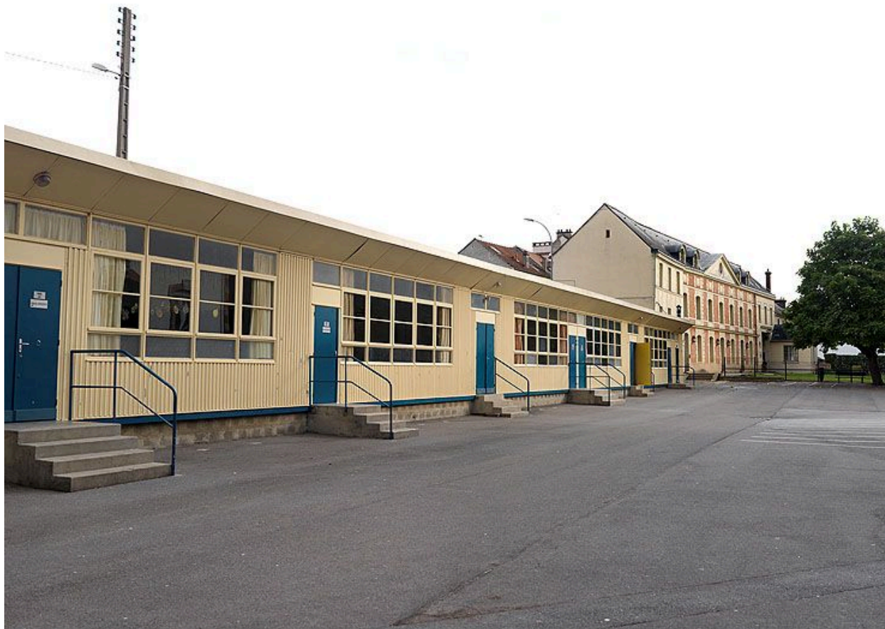
Les bâtiments orientaux, vus du nord : préfabriqués des années 1950 au premier plan, bâtiment du XVIIIe siècle au fond.
