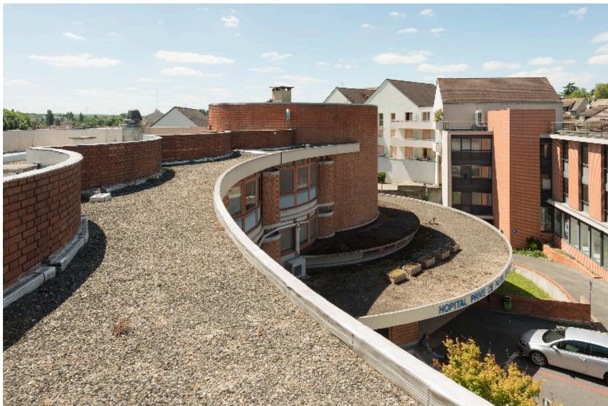
Vue du toit-terrasse et de la façade principale.
