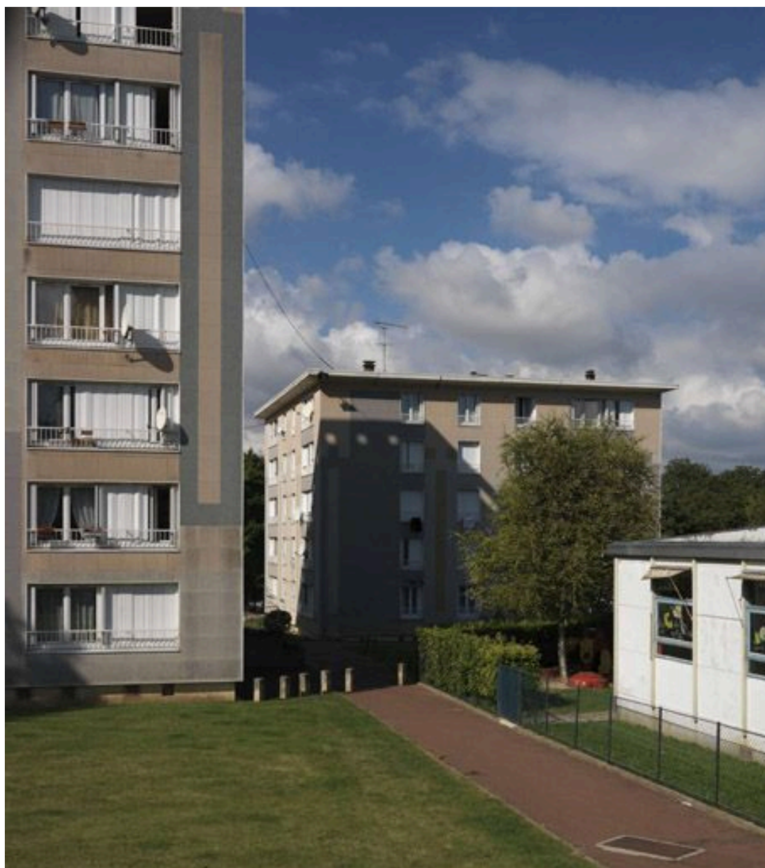
La cité des Bergeries à Draveil : immeubles n°29 (à gauche) et 27 près de l'allée des Ecoles.
