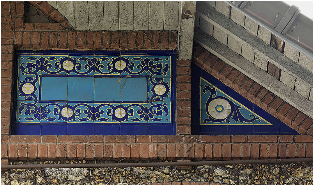
Détail de la façade sur le jardin: panneaux de céramique ornant les parties hautes, sous le toit débordant.
