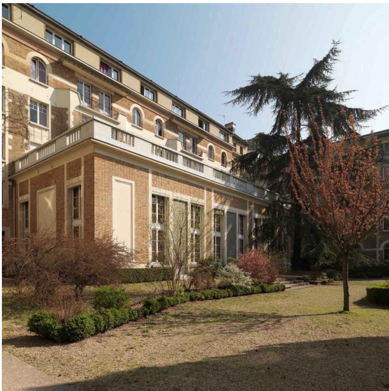
Le bâtiment de la salle des fêtes en rez-de-chaussée et formant saillie sur la façade sud.
