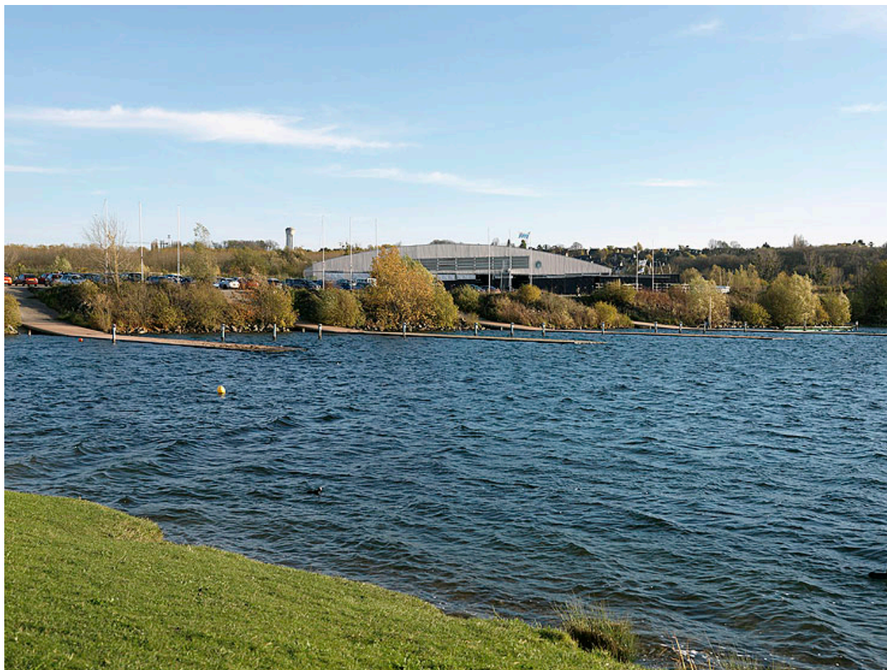
La partie orientale du lac de Vaires, vue de la rive nord, avec ses pontons et le hangar à bateaux.
