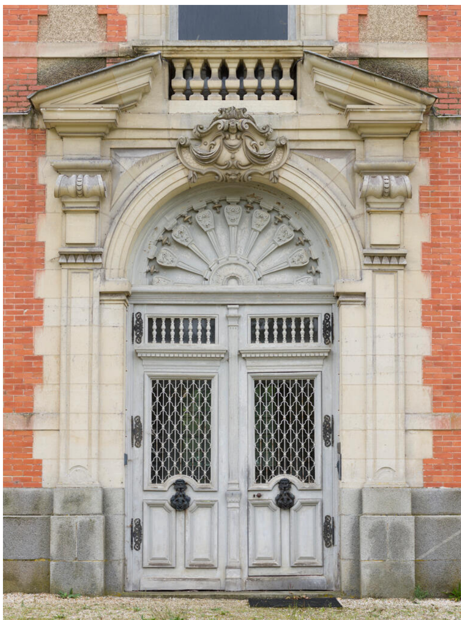
La monumentale porte d'entrée sur la façade nord.
