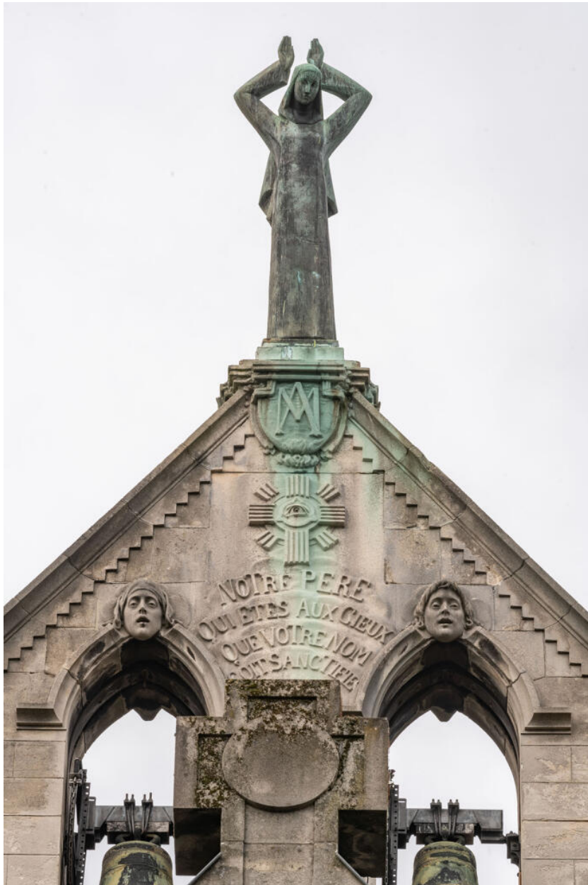
Chapelle Notre-Dame-des-Airs, clocher-mur à deux baies, surmonté par la statue de Notre-Dame des Airs de Pierre Meauzé
