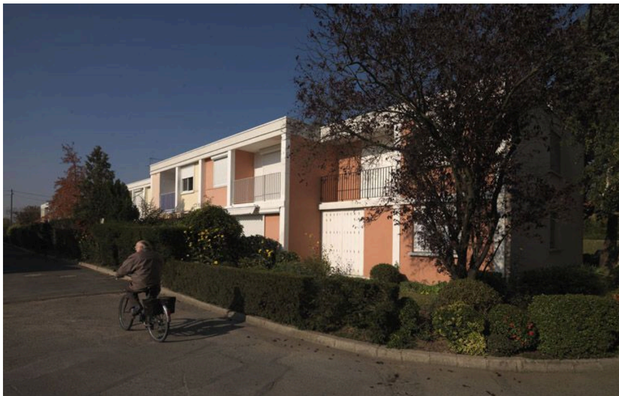
Bâtiments individuels en bande le long de l'allée Eugène-Delacroix.
