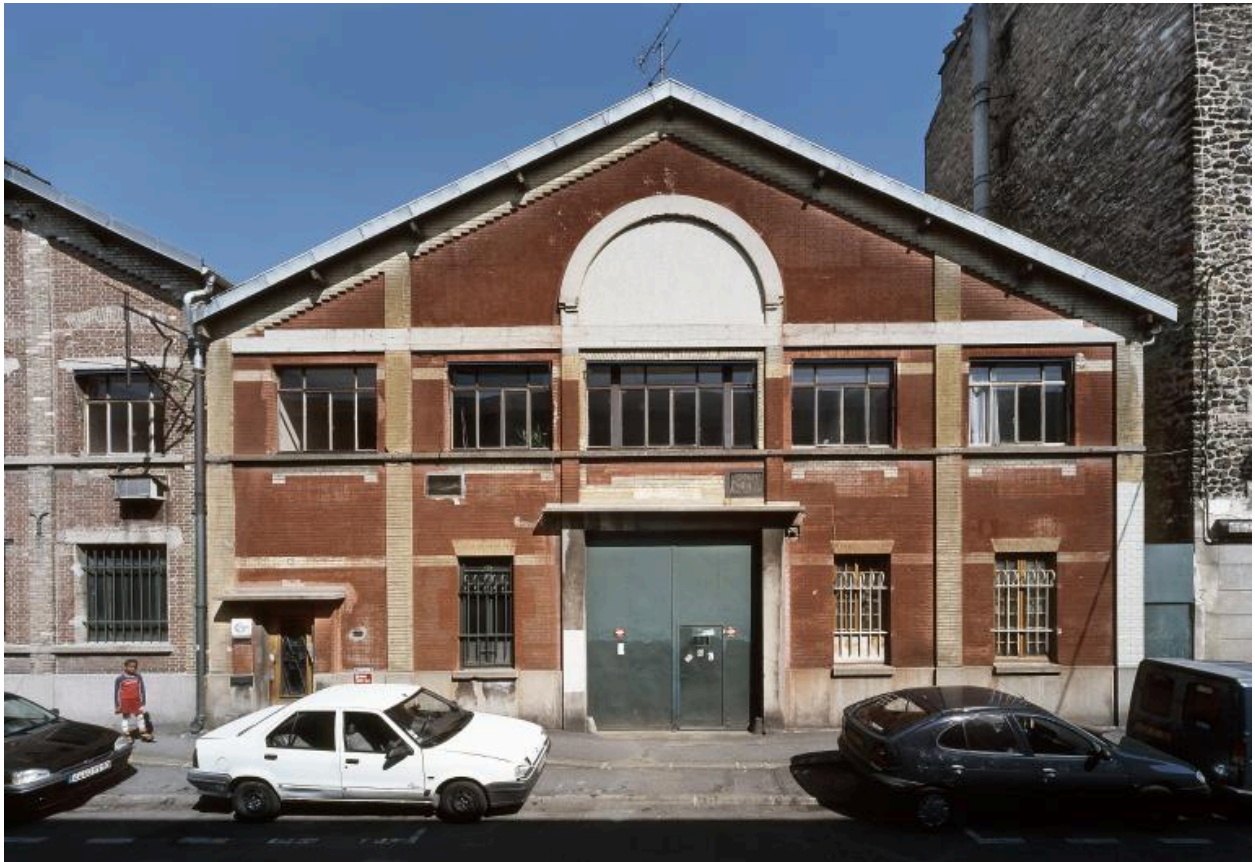
Pignon droit de l'atelier des machines outils Rateau (1913-1916, remanié en 1948).
