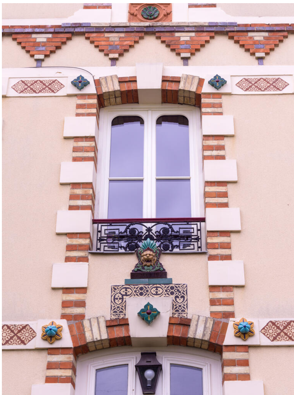
Vue de la façade nord, détail de ses décors.
