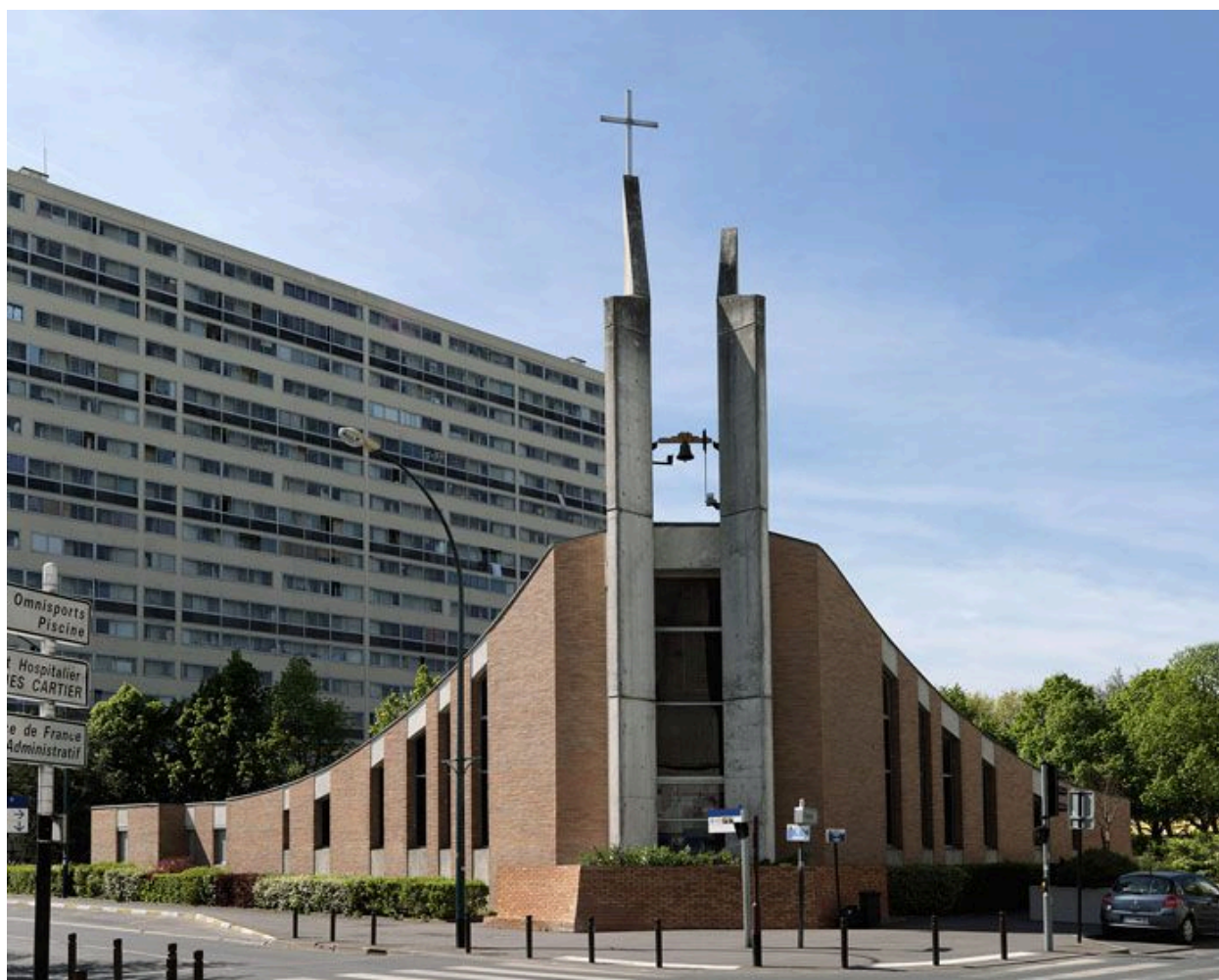
Façades sur rue et clocher de l'église Saint-Paul.
