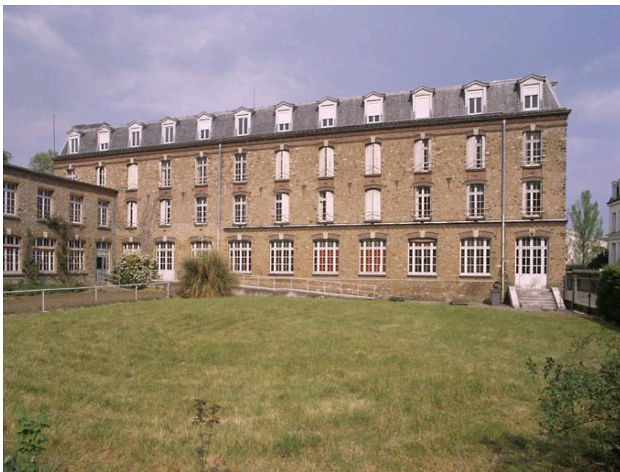
Façade sud du bâtiment des retraites dit Second noviciat construit en 1894.
