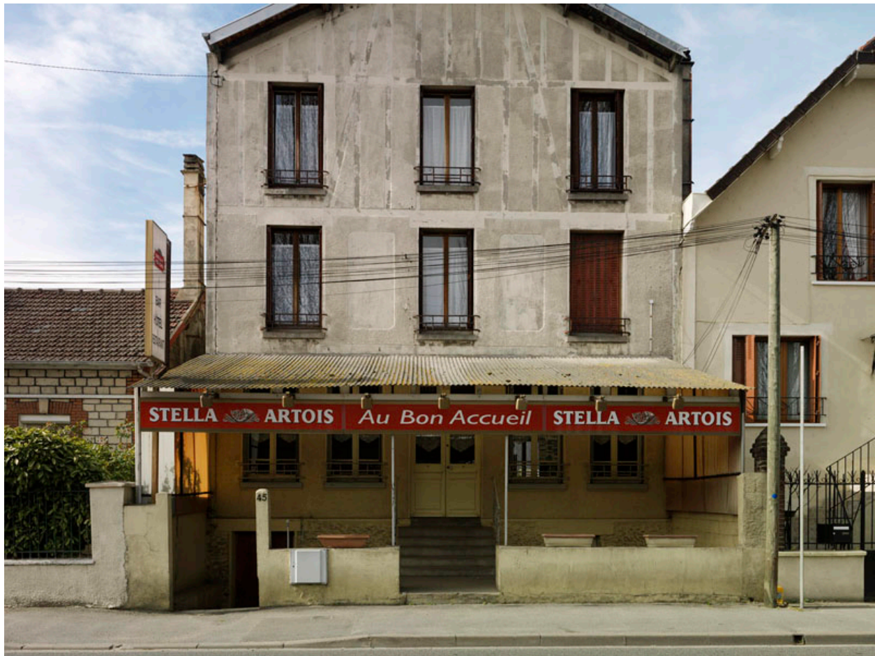
Persan. Le quai de l'industrie. Bar restaurant "Au bon accueil". Élément de phrase urbaine.
