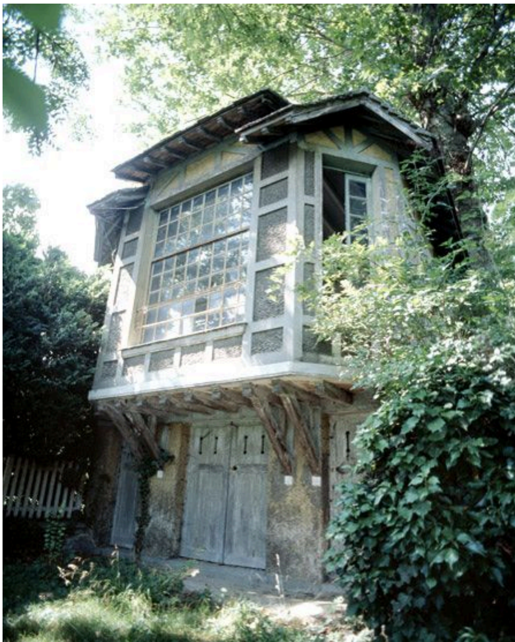
Pavillon surplombant la Marne servant de garage à bateau au rez-de-chaussée et de salle à manger d'été au dessus, île de Beauté.
