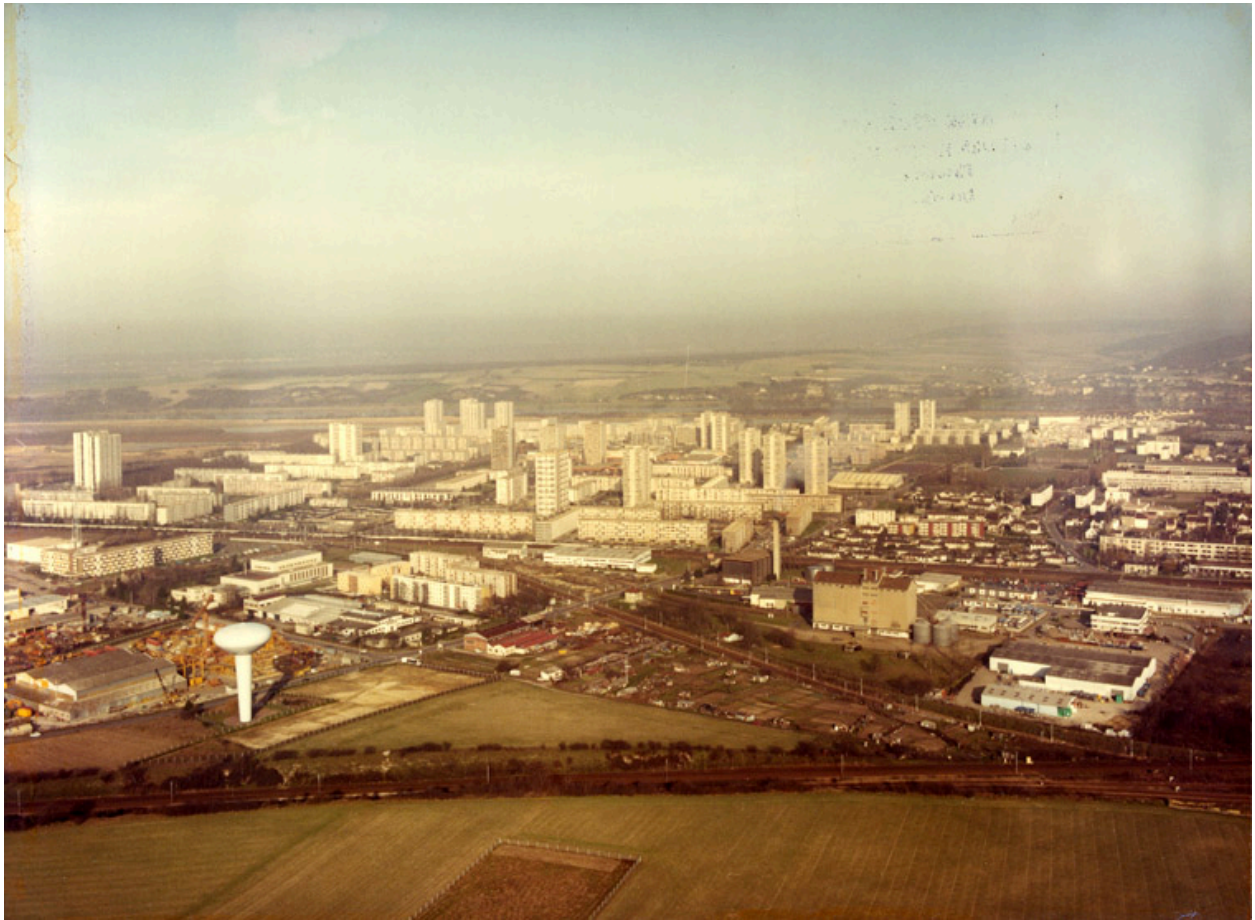
Vue aérienne du Val Fourré en 1984 prise en direction du nord. (Fonds Credop).
