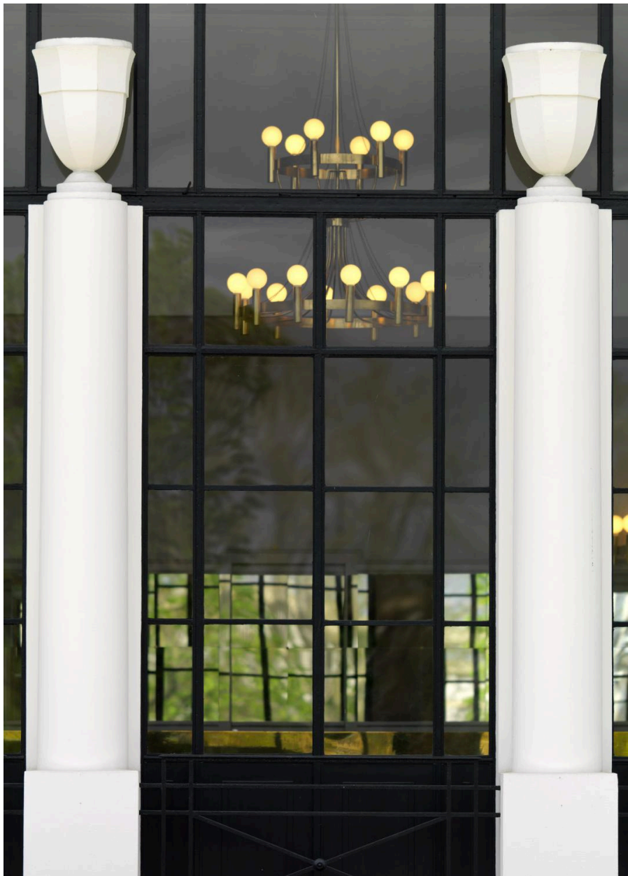
Façade, partie centrale, piliers couronnés de vases en ronde-bosse
