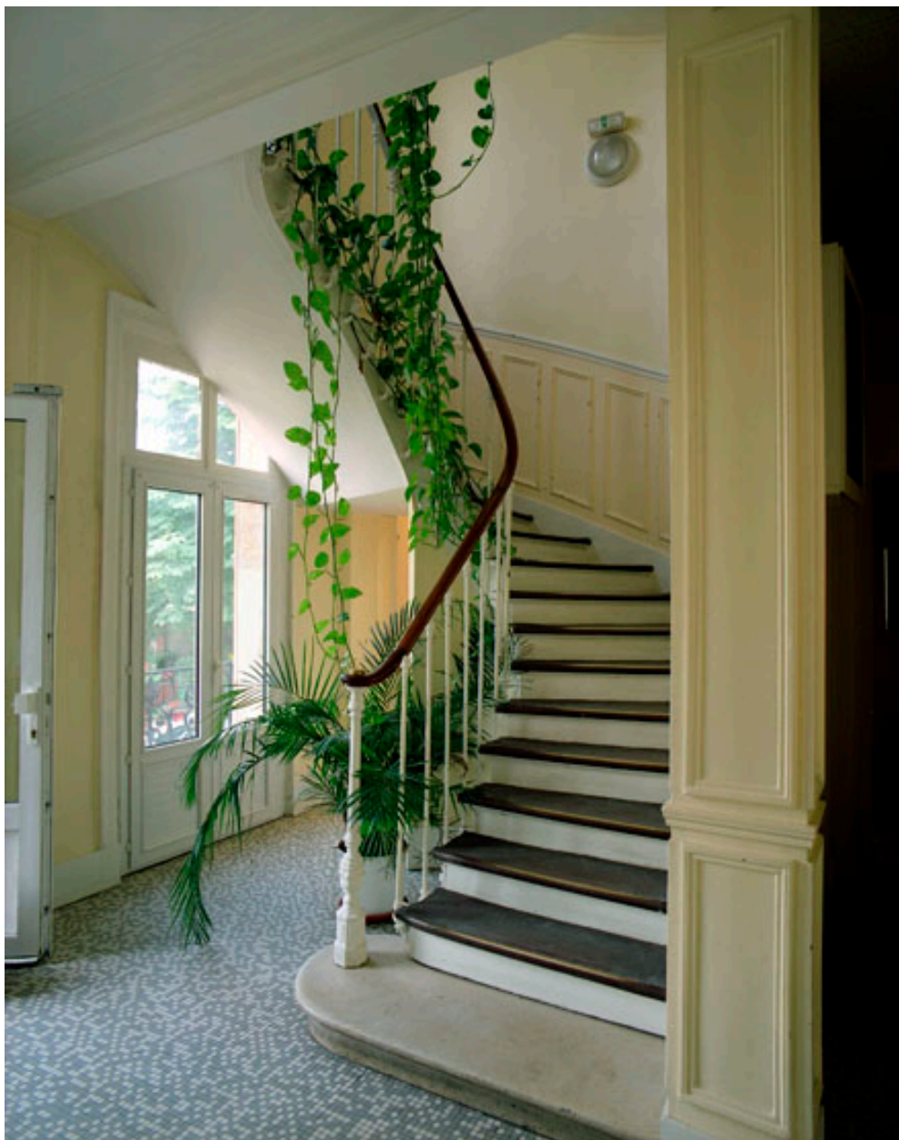
Vue de l'escalier depuis le vestibule.
