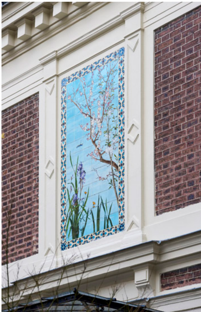
Vue rapprochée du décor en céramique de la façade arrière.
