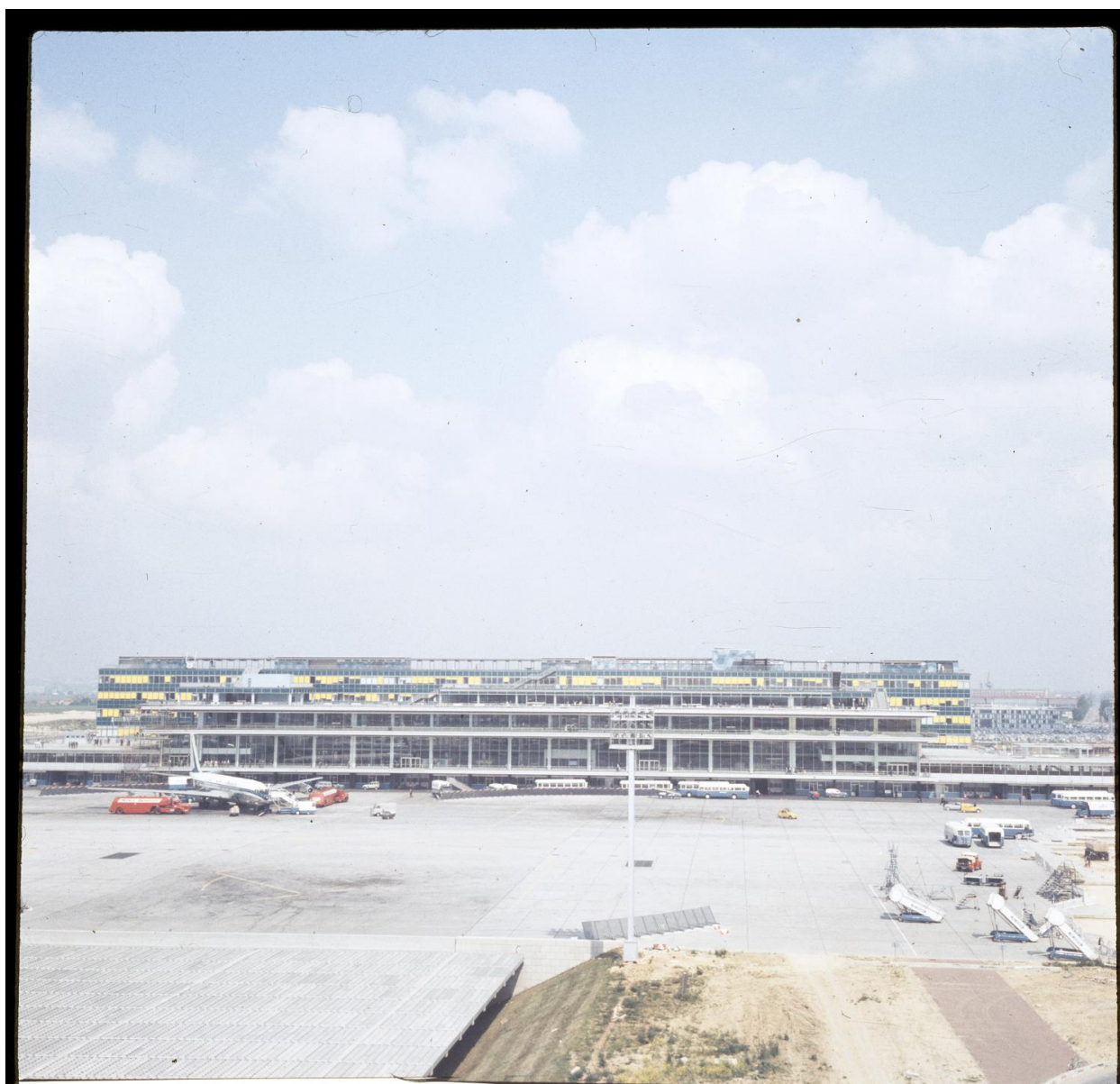
1961 1966, les Installations Terminales vues depuis la tour du PCR.
