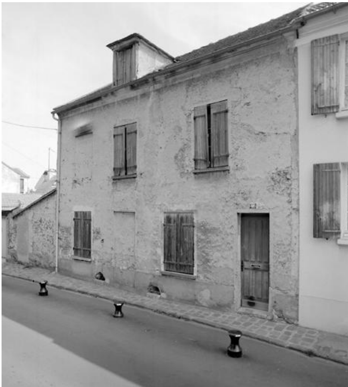
Vue d'ensemble de la maison. La façade porte un enduit de plâtre gros.
