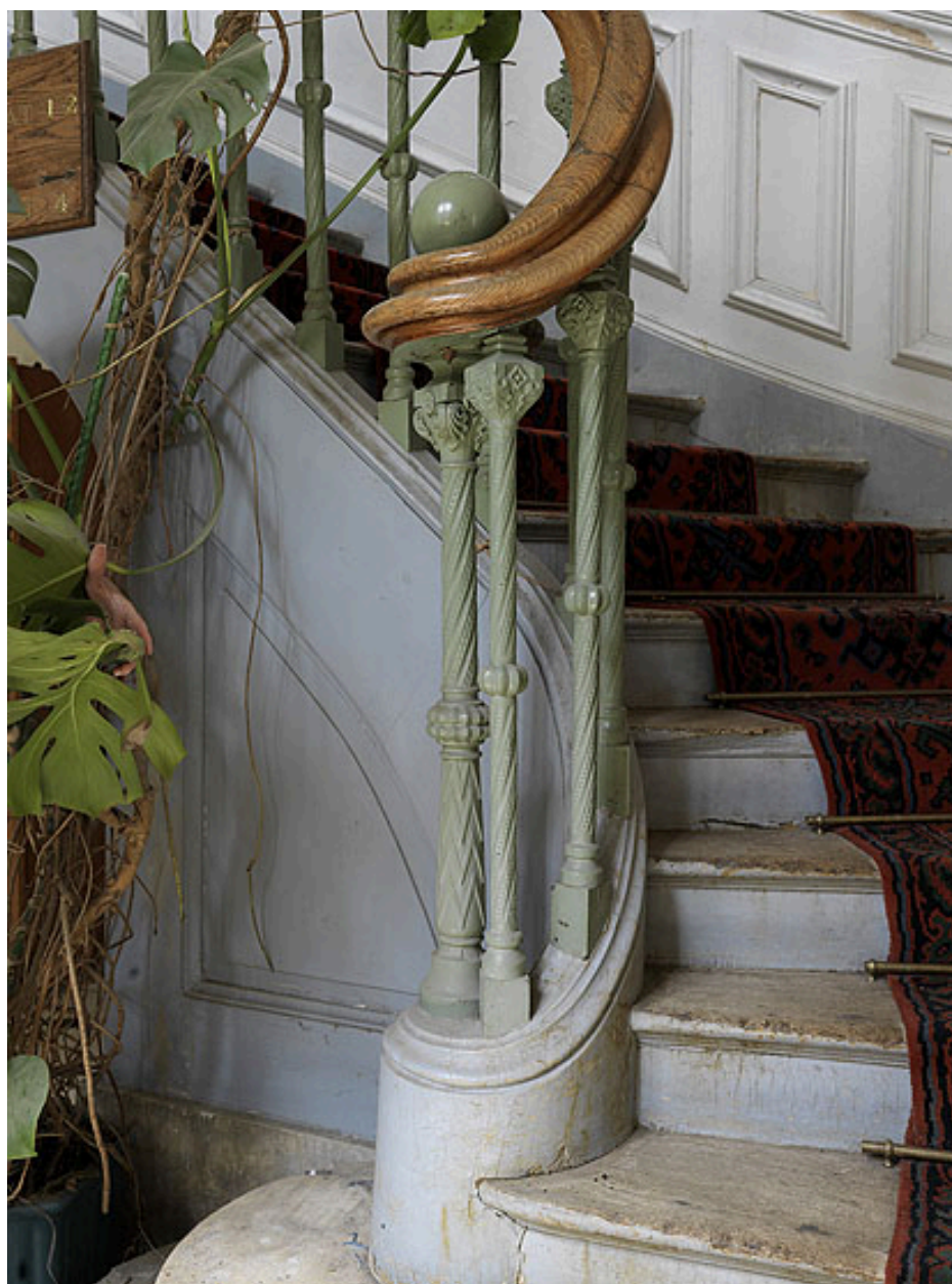
Détail du départ de la rampe d'escalier.
