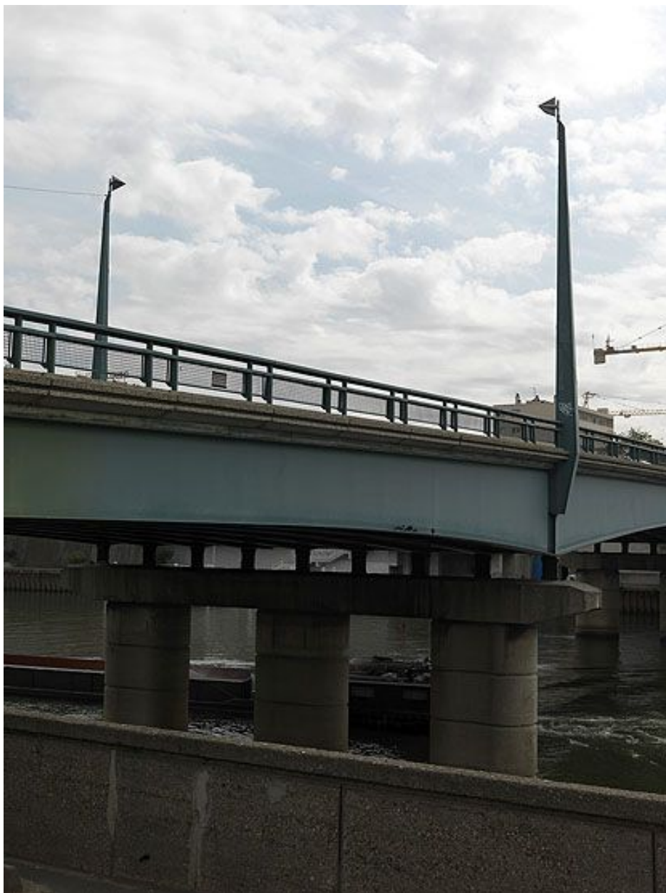
Ivry-sur-Seine. Pont d'Ivry (n°2). Vue rapprochée d'une pile.
