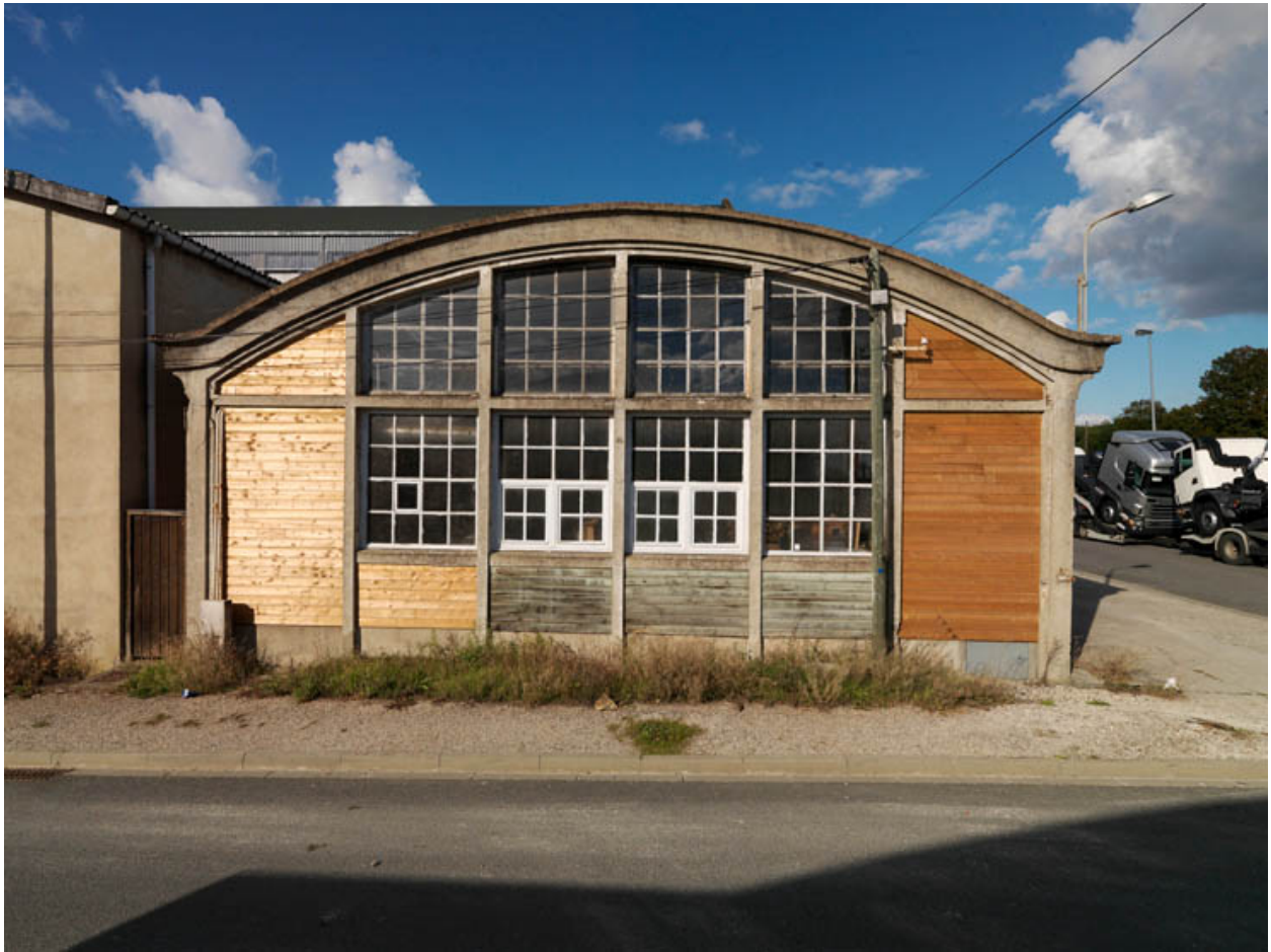
Garage de voitures puis menuiserie (1917).
