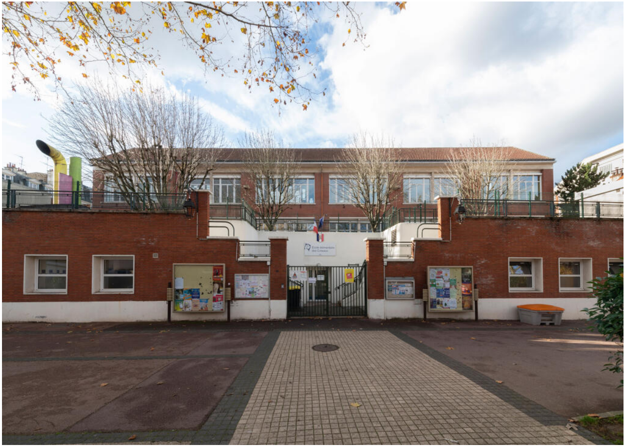
École des Coteaux, entrée du bâtiment de 1938 par l'avenue Berard Palissy
