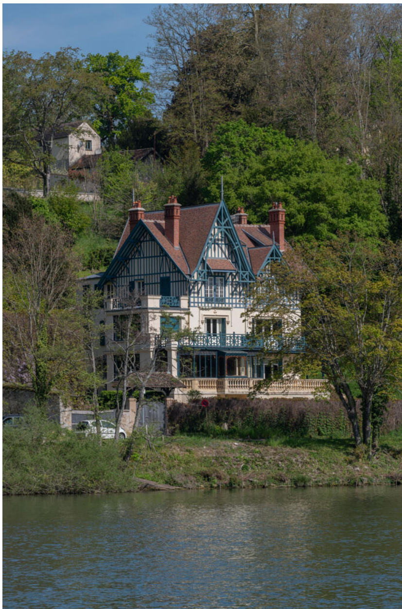
Vue générale de la villa.
