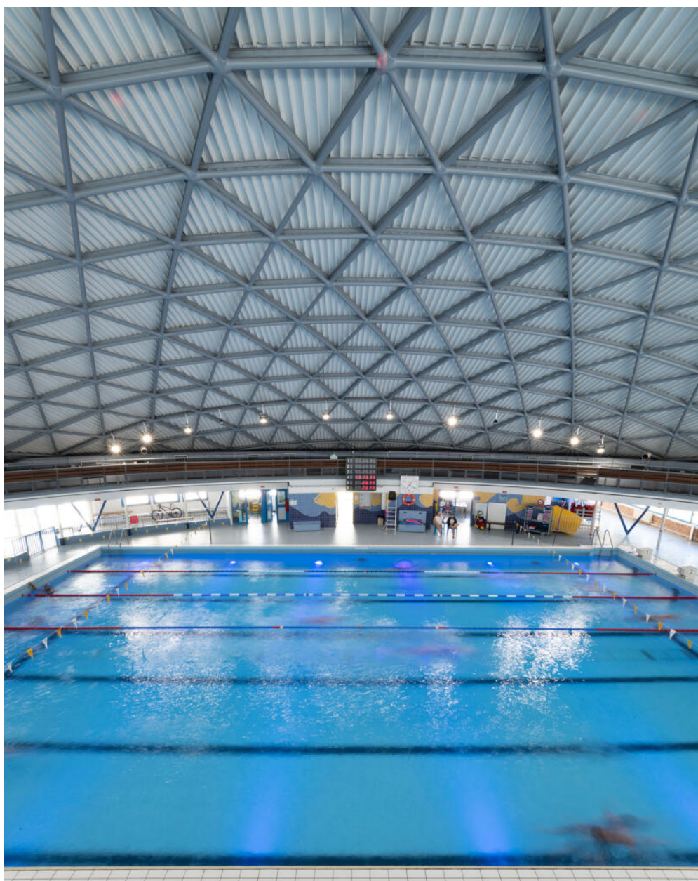
Stade nautique de Drancy. Vue du bassin de compétition depuis le plongeur.
