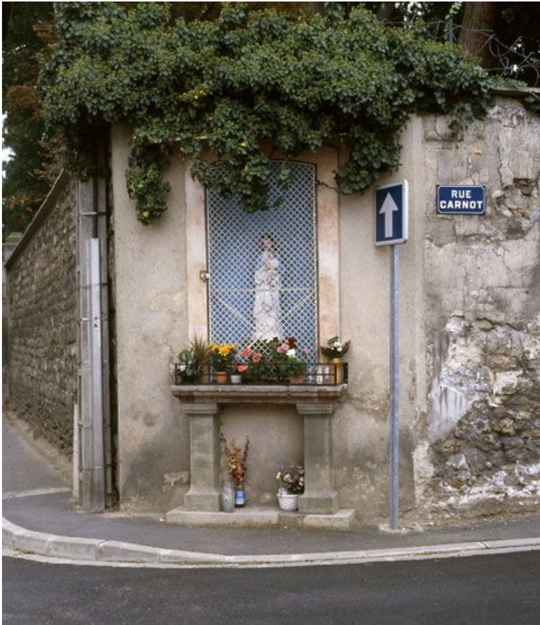
Vue d'ensemble de l'oratoire situé à l'angle de la rue Carnot et de la rue du Maréchal Delattre de Tassigny.
