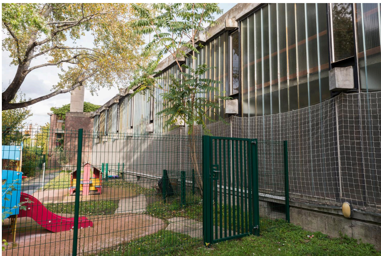
Détail des espaces vitrés de desserte de l'aile ouest.
