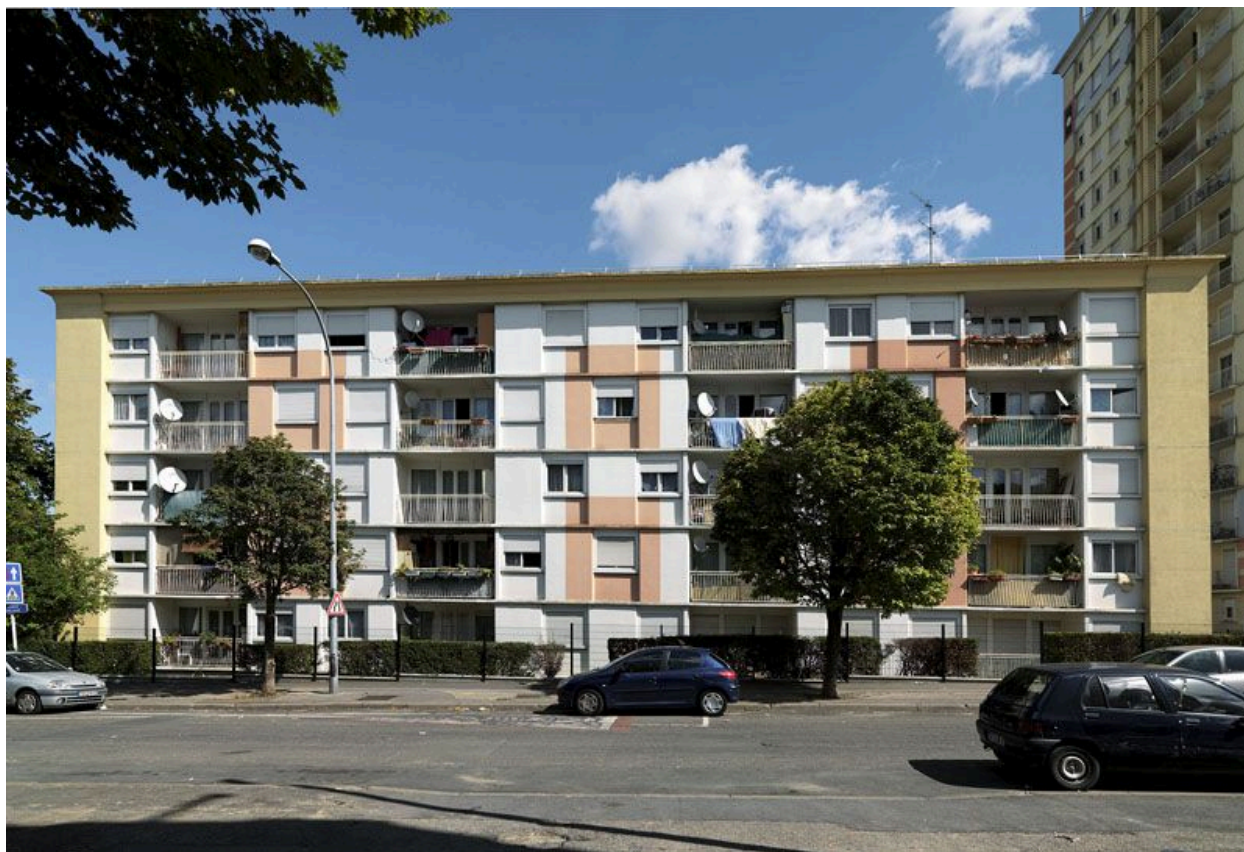
Cité Parat. Vue d'un bâtiment de la cité, construite en 1962-1966, par P. Durand (architecte).
