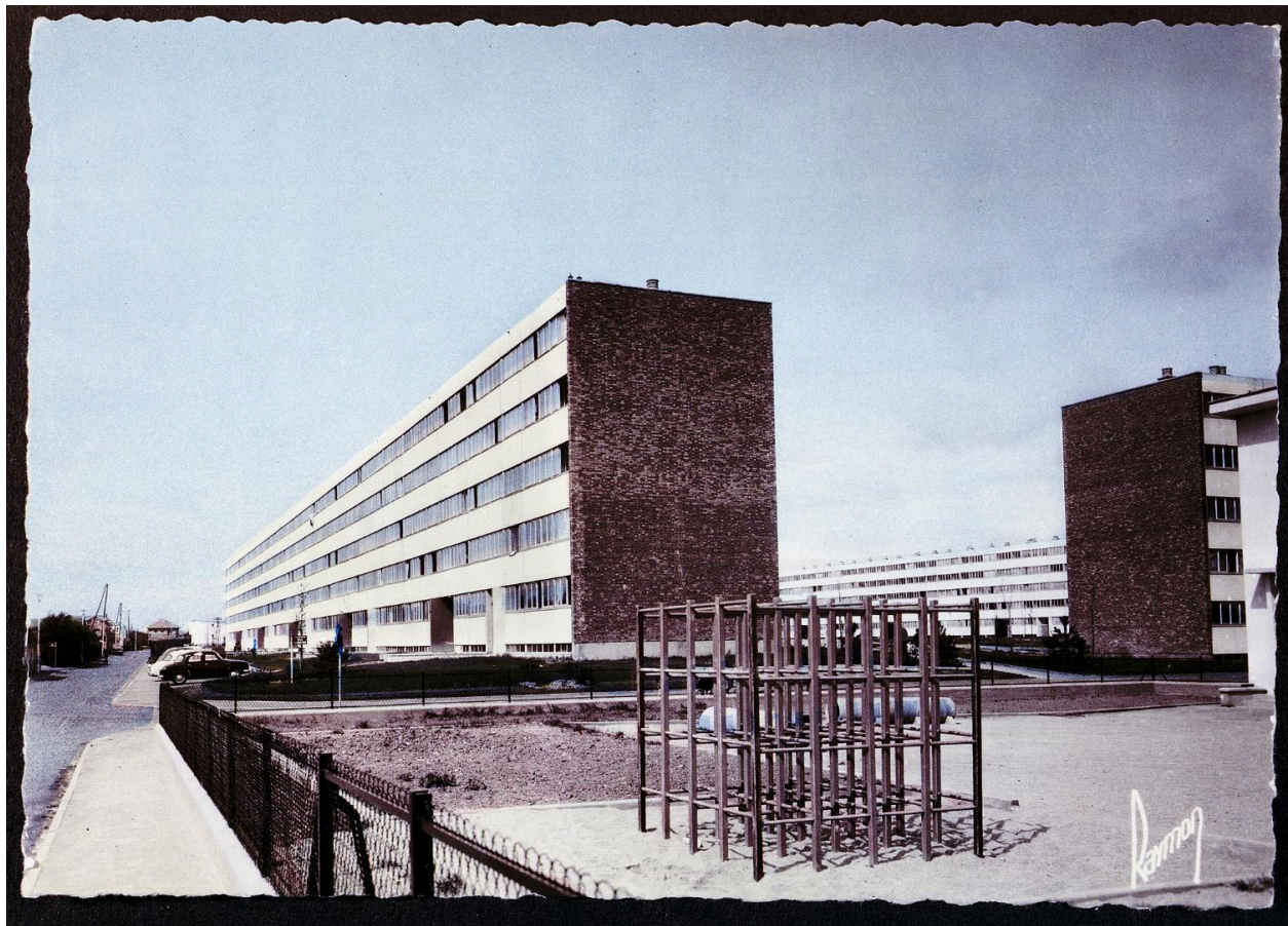
Vue d'une partie des bâtiments, à l'arrière de la rue du Plein Midi.
