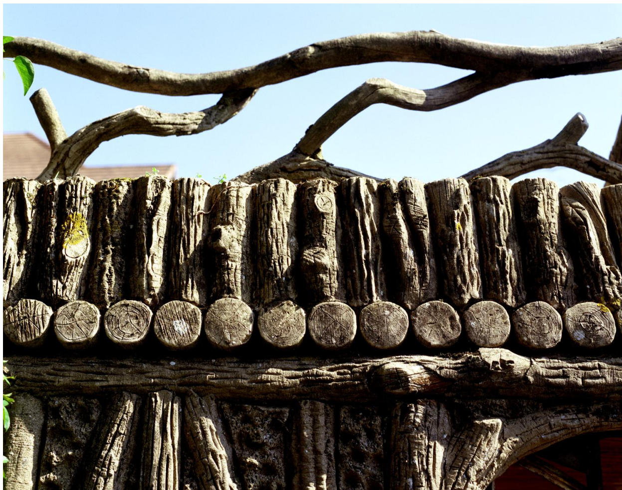
Détail de la mise en oeuvre des éléments de ciment (imitant le bois écoté) qui ornent le toit-terrasse du kiosque de jardin.
