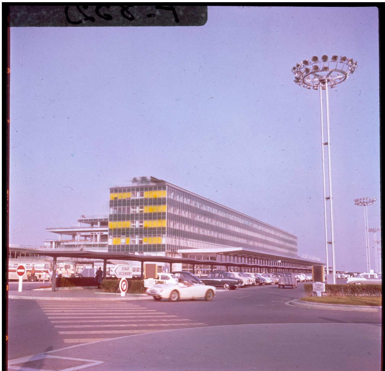
1961, les Installations terminales vues depuis le nord est.
