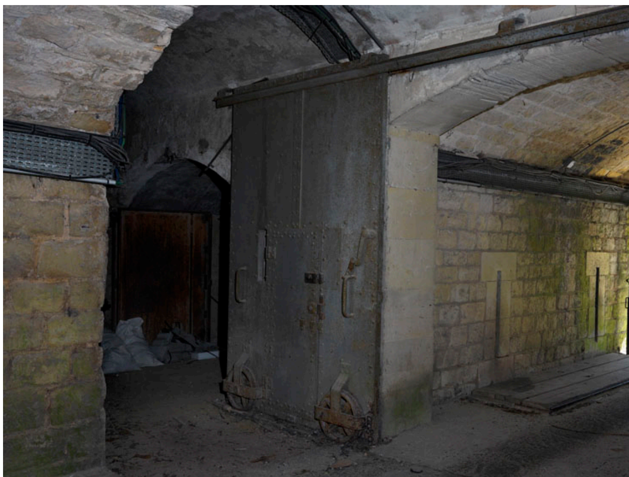
Vue intérieure du rempart sud : le mur oriental du passage d'entrée, avec les créneaux de réception du pont coulissant.
